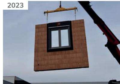
Gründung max-Bausysteme; Fensterelemente & Ziegelfertigwände
