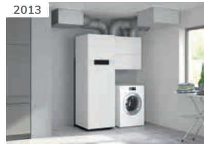
Gründung ETZI-Haustec (Heizung, Klima, Lüftung, Sanitär)
