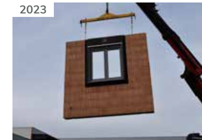
Gründung max-Bausysteme: Fensterelemente & Ziegel- fertigwände
