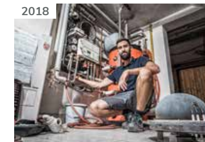
Übernahme LETTENMAYR Installationen in Bad Hall
