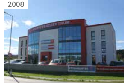
Bau des ETZI-Kompetenzzentrums in Vorchdorf
