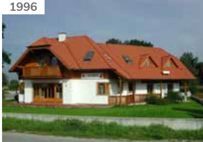
Bau eines Bürogebäudes in Pettenbach
