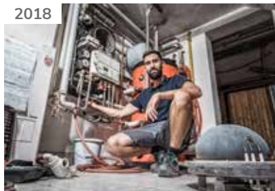
Übernahme LETTENMAYR Installationen in Bad Hall
