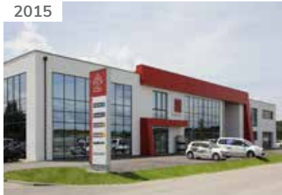
Bau und Eröffnung der ETZI-Wohnwelt
