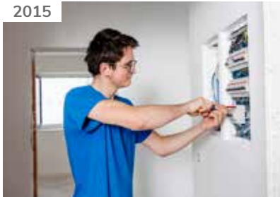
Gründung ETZI-Haustec (Elektro)
